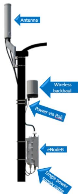
Figura 24. Ejemplo de equipos auxiliares que requieren una small cell en que la antena no está integrada en la farola sobre la que se instala. Fuente: SCF.
