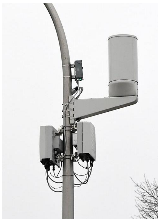
Figura 43. Small Cells instaladas en un báculo de iluminación no adaptado para esta clase de equipos.
