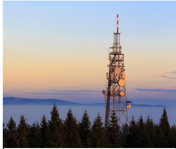
Figura 44. Macro cell en un entorno poco denso, con el objetivo de dar cobertura a una amplia extensión de territorio.
