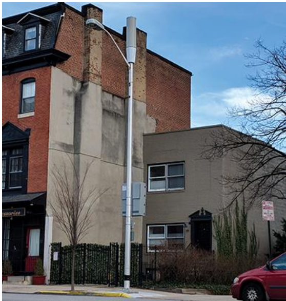
Figura 21. Small cell instalada sobre una farola preexistente en Baltimore, USA. Fuente: Crown Castle.
